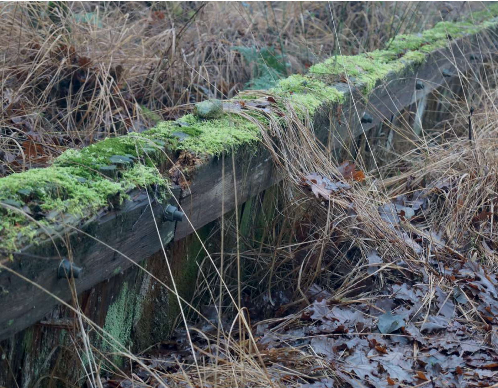
Een damwand – in dit geval van hout - in het Korenburgerveen (Gld).
