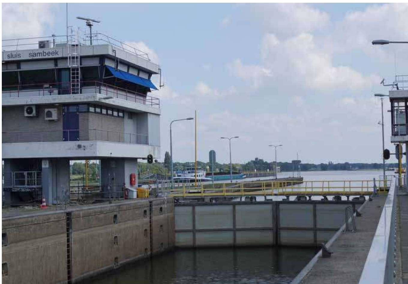
Het sluiscomplex bij Sambeek enkele weken na de overstroming.
